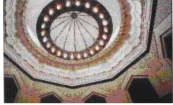
صورة (١٣) استخدام الشخصىخة بمبنى المشىخة
